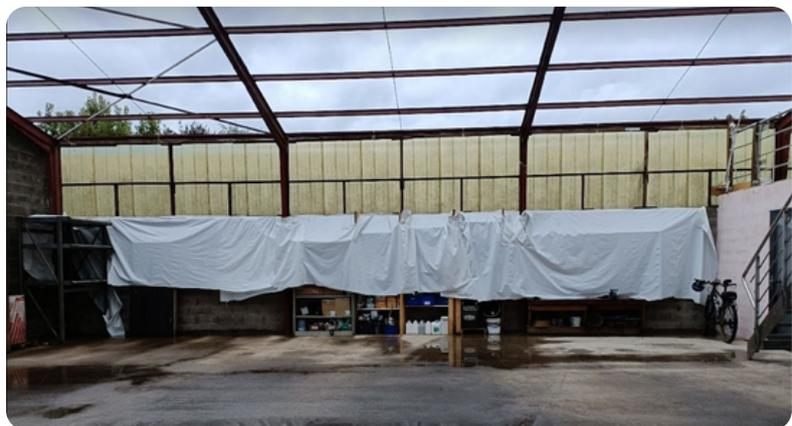
Une nouvelle couverture de type « bac acier » a ainsi pu être montée sur la structure métallique existante.
