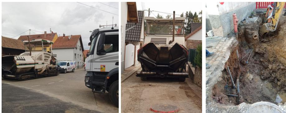
L'impasse de la croix a fait l'objet d'importants travaux de voirie au mois d'octobre. Dans un premier temps, un diagnostic du réseau d'eau et d'assainissement a été réalisé par le SDEA avant d'envisager la réfection de l'enrobé. Ce diagnostic a mis en évidence des faiblesses au niveau des bouches à clés et du poteau incendie qui ont été remplacés.
