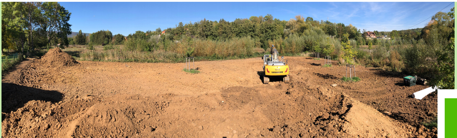
Site pendant les travaux
