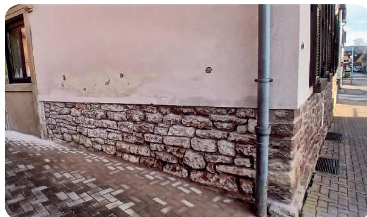
Le crépi a également été enlevé sur la partie du sous-bassement du bâtiment principal de l'école afin de stopper les remontées d'humidité, qui endommageaient murs et encadrements de fenêtres en grès.
