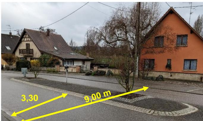
La mise en place d'un passage piéton devra être accompagnée d'un recul de 5 m du stationnement pour éviter les masques à la visibilité
