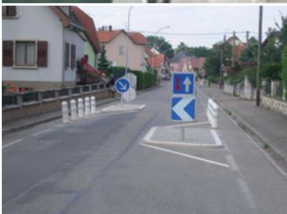
Exemple d'aménagement de double écluse dans le Bas-Rhin. La signalisation d'alternat d'une écluse n'est pas obligatoire. Toutefois, si elle est implantée d'un côté de l'aménagement, elle doit l'être également de l'autre côté.
